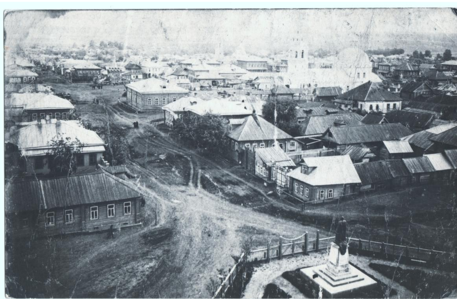
Илл. 6. Нижегородская область, Большемурашкинский район, рп. Большое Мурашкино, реконструкция ВЛ 0,4 кВ (Большемурашкинский РЭС) - 2026 г.
